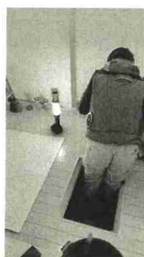
配管は水道屋さん
