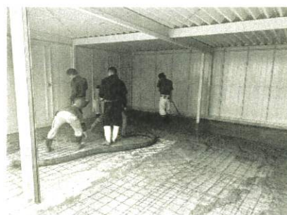
ガレージの中のコンクリート打ち
