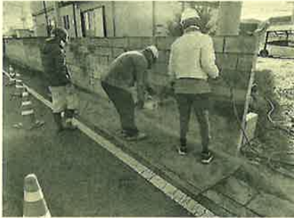
ブロックにカッターを入れて撤去
