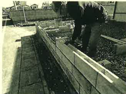
1段のみ新規ブロックを積みました
