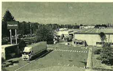
パナソニック真岡工場の外観
