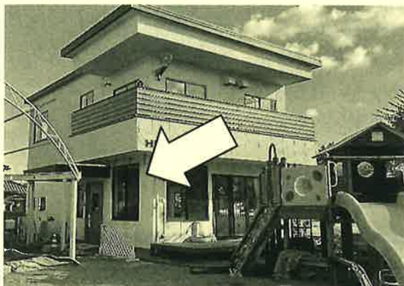
この窓を改造して両面から出し入れできる様にしたいとのご要望♪
