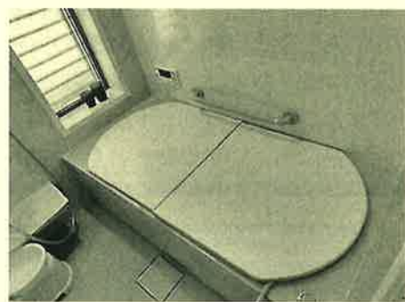
手すりと断熱浴槽 蓋も断熱入り
