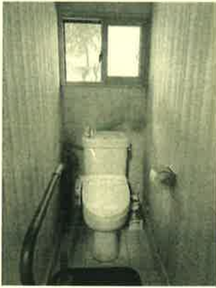
タイル張りの床の解体から
