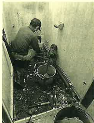
バケツリレーで土出し
