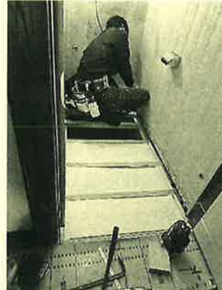
大工さんの床張り
