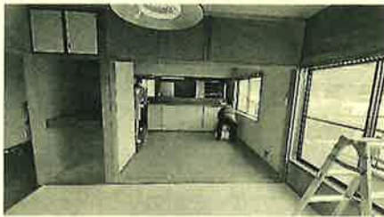
35年前に弊社で新築された 愛着のあるお家を解体
