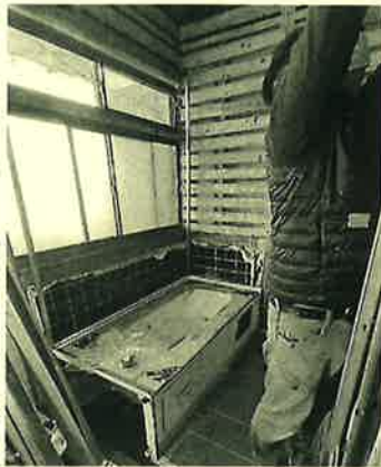
解体工事の様子 痛んでいた土台も修復
