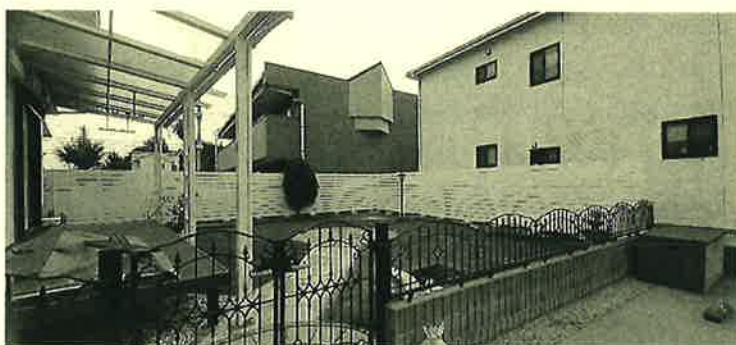
お隣との境界は真っ白なフェンスを施工 可愛らしいお庭が完成しました!!
