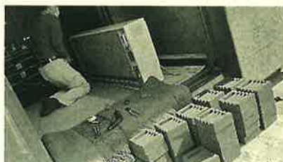
電気でレンガを温める仕組みです
