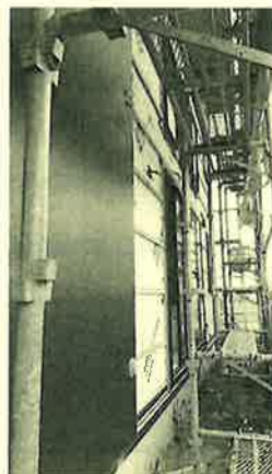
外壁工事も同時進行です
