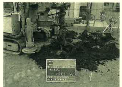
直径60センチのコンクリート杭
