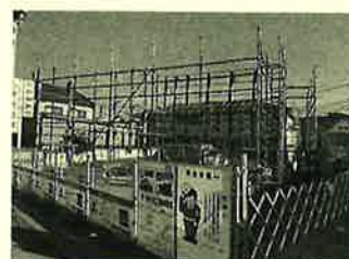
現場の安全を守るため囲いもしっかりと
