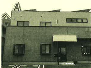
施工前の外観写真
