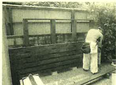
ブロック塀隠し用フェンス
