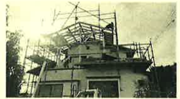
2階の一部増築工事
