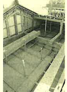
1階の屋根に乗せます
